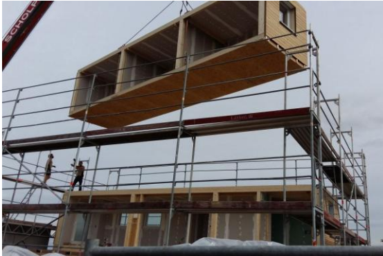
Montage auf Fundament, Bodenplatte oder Kellergeschoss
